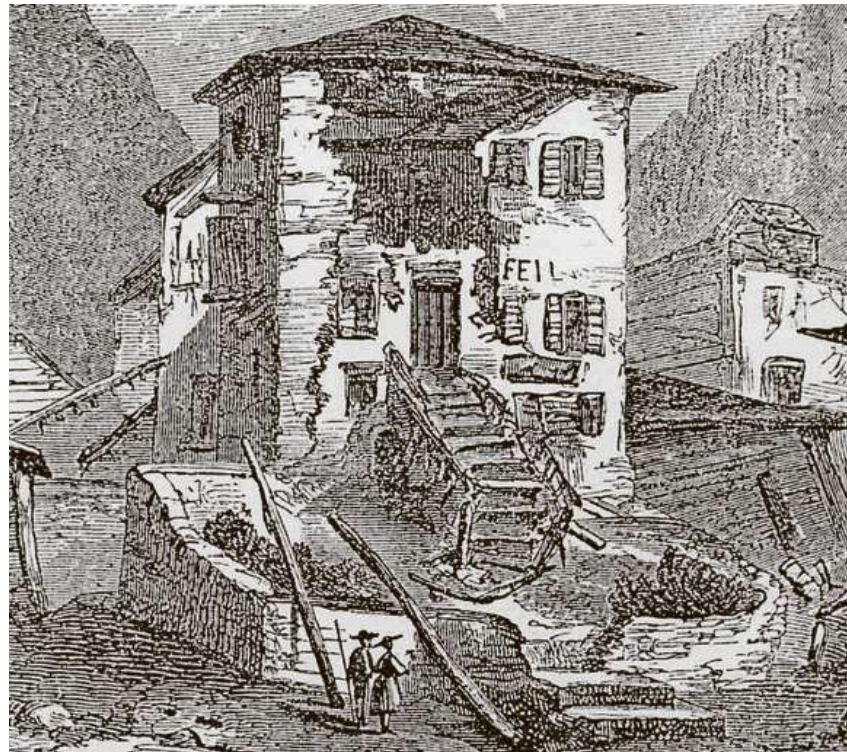
Das stärkste Beben der Schweiz im 19. Jahrhundert zerstörte oder beschädigte zwischen Visp und St. Niklaus (Wallis) mehr als 200 Häuser. Bild zvg
