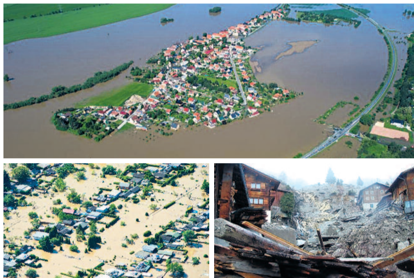
Schäden, soweit das Auge reicht: Die Gebäudeversicherung hilft im Notfall.
