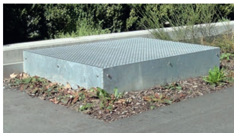
Erhöhte freistehende Rauch- und Wärmeabzugsanlage
